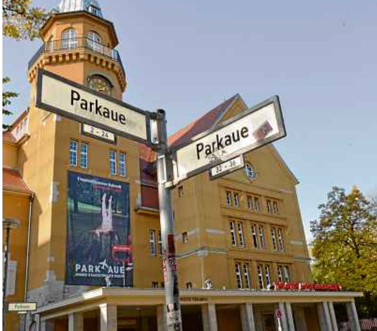
Von Außen nicht zu sehen: Der große Theatersaal ist frisch saniert
