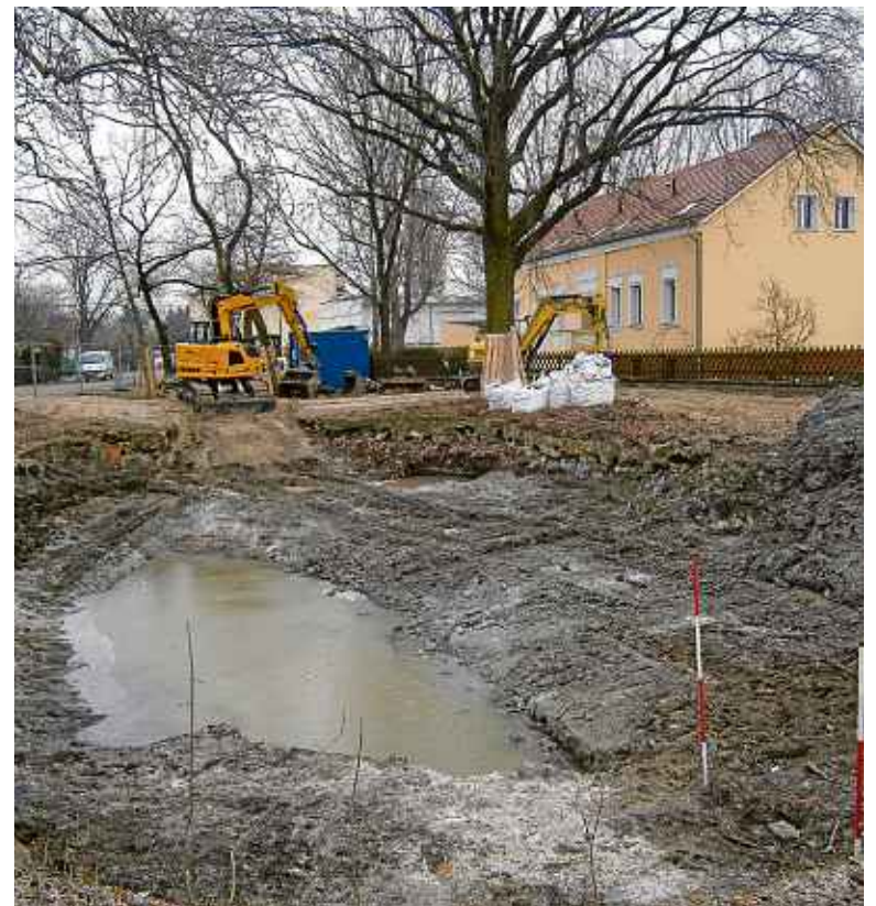
Zehn Monate lang wurde der Dorfteich in Wartenberg saniert.
