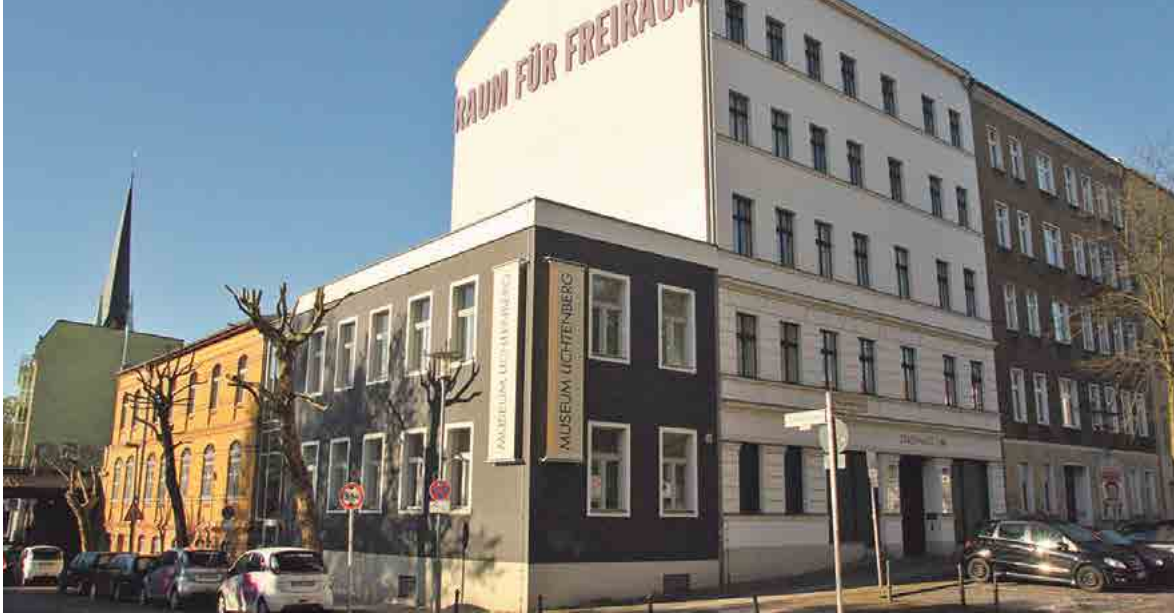
Das Museum Lichtenberg an der Türschmidtstraße 24 wird bis zum Sommer 2020 in Teilen renoviert.
