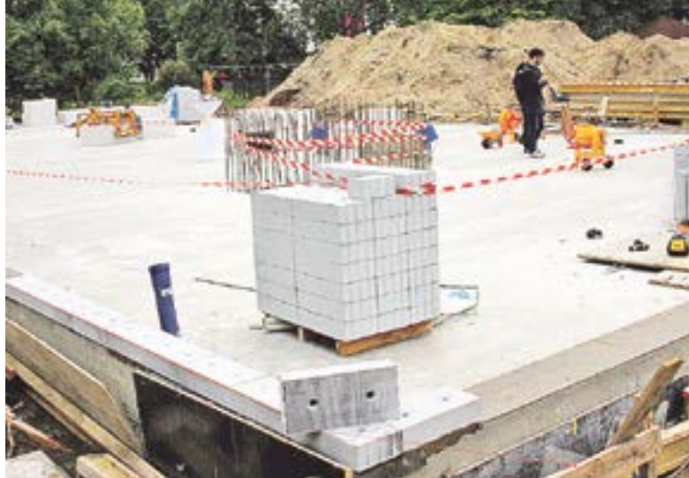
Der Kitausbau geht weiter.
