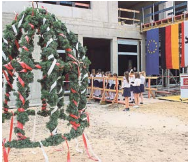
Ende August wurde Richtfest im Römerweg 120 gefeiert. Die Einweihung folgt im kommenden Jahr.
