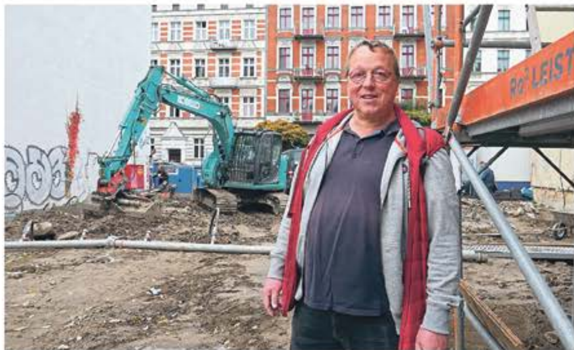
Michael Heinsch-Kirch auf der Baustelle der SozDia Stiftung in der Pfarrstraße.
